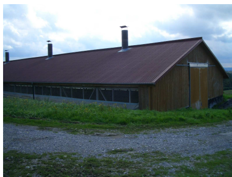
Abbildung 2. Aufzucht und Maststall A1 von Betrieb A
