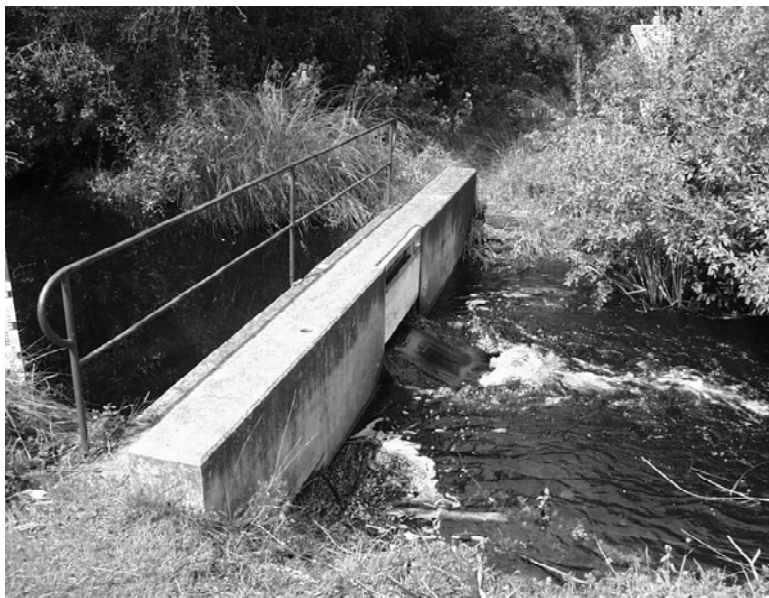
Bild 2 Wehr zur Wasserstandsregelung im Landesgrenzgraben.
